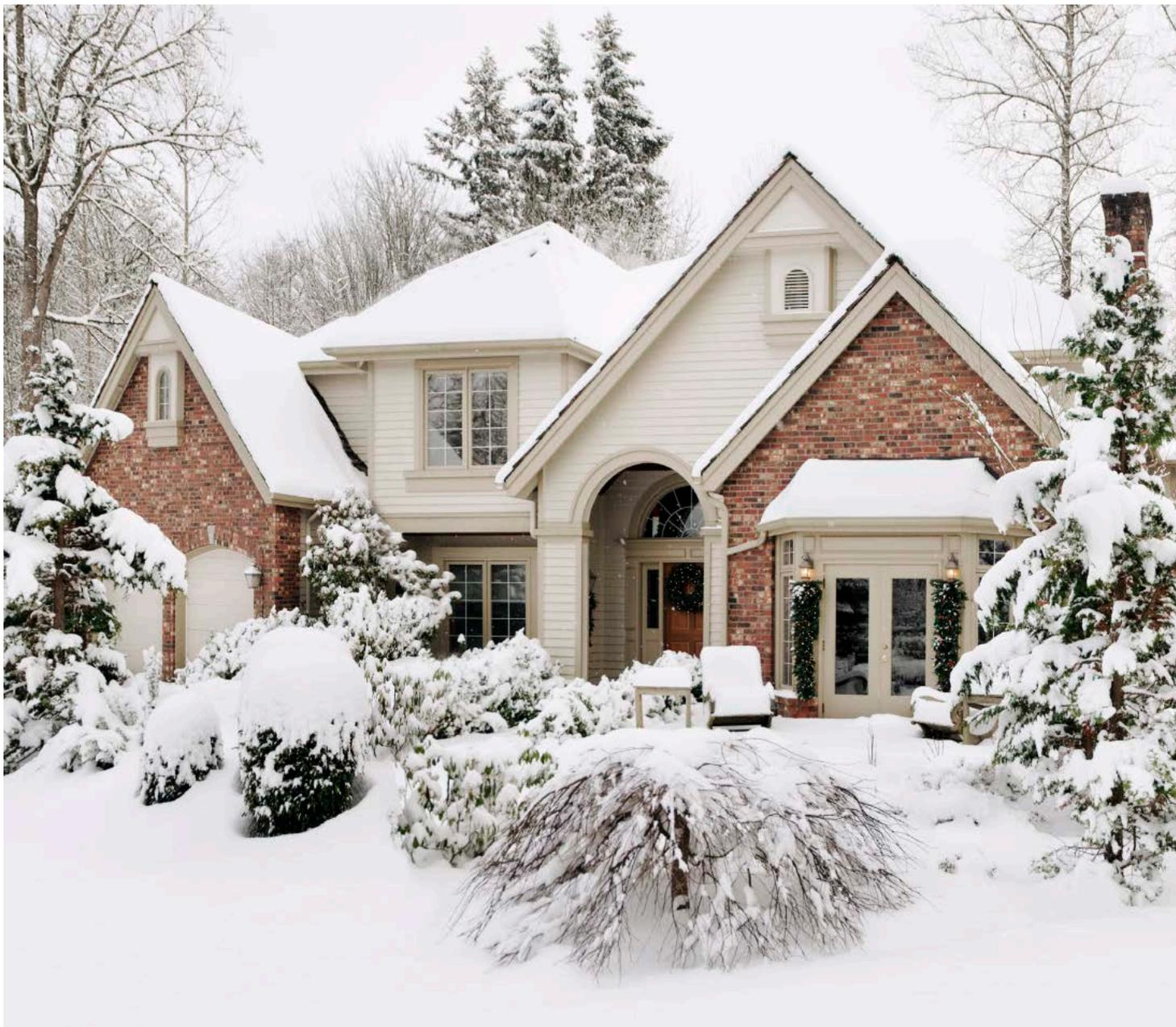
Кирпич S.Anselmo производится по технологии ручной формовки. Глиняный шар с высоты падает в форму, заполняя всё пространство. Такой способ (в отличие от метода экструзии, когда глиняная масса выдавливается на транспортерную ленту и нарезается на куски), дает однородную, мелкопористую структуру кирпича. Подобная структура позволяет кирпичу не слоиться и выдерживать тысячи циклов замораживания и оттаивания без снижения прочности материала.
