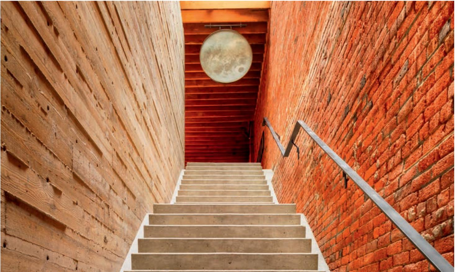
Изготовленный по технологии ручной формовки кирпич S.Anselmo с легкостью выдерживает бесконечные циклы замораживания и оттаивания. Все материалы S.Anselmo полностью отвечают Европейским требованиям по морозостойкости. Им присвоен высший класс морозостойкости F2.
